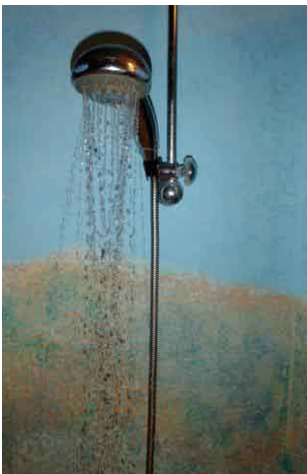
1. Ściana przy wannie. Farba akrylowa oraz dekoracja siloksanowa. Zabezpieczona polimerem Stone Tone II w połysku oraz woskiem Easy Shine.
